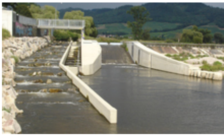
Wasserkraftwerk in Offenburg
